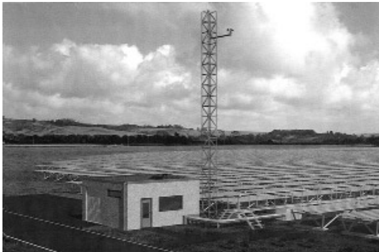
Figura 2.12. L'idea alla base dell'Argus (e di alcuni progetti dello Ska) è quella di usare una schiera di antenne fisse elementari e di combinare elettronicamente i loro segnali per puntare "virtualmente" l'apparato verso qualunque zona del cielo prescelta. Qui vediamo una delle antenne che potrebbero formare i radiotelescopi del futuro. (Cortesia Nfra-NI)
