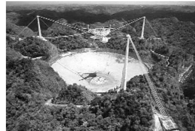
Figura 2.6. La gigantesca antenna parabolica del radiotelescopio di Arecibo, incastonata in un avvallamento naturale dell'isola caraibica di Puerto Rico. Con i suoi 305 metri di diametro, è attualmente la più grande antenna esistente al mondo.
